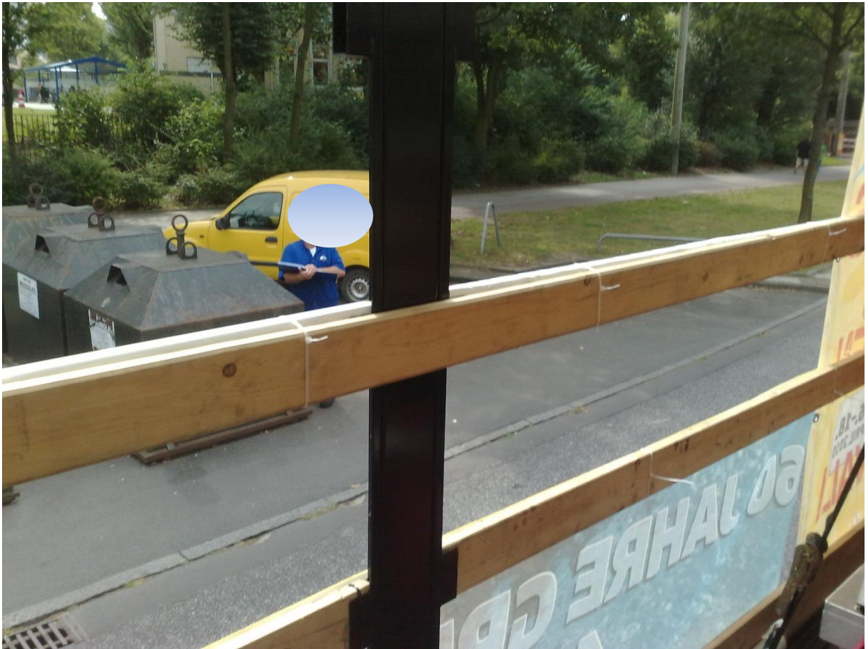
Verstärkung der Spriegel mit Überlappung gegen Herausdrücken
