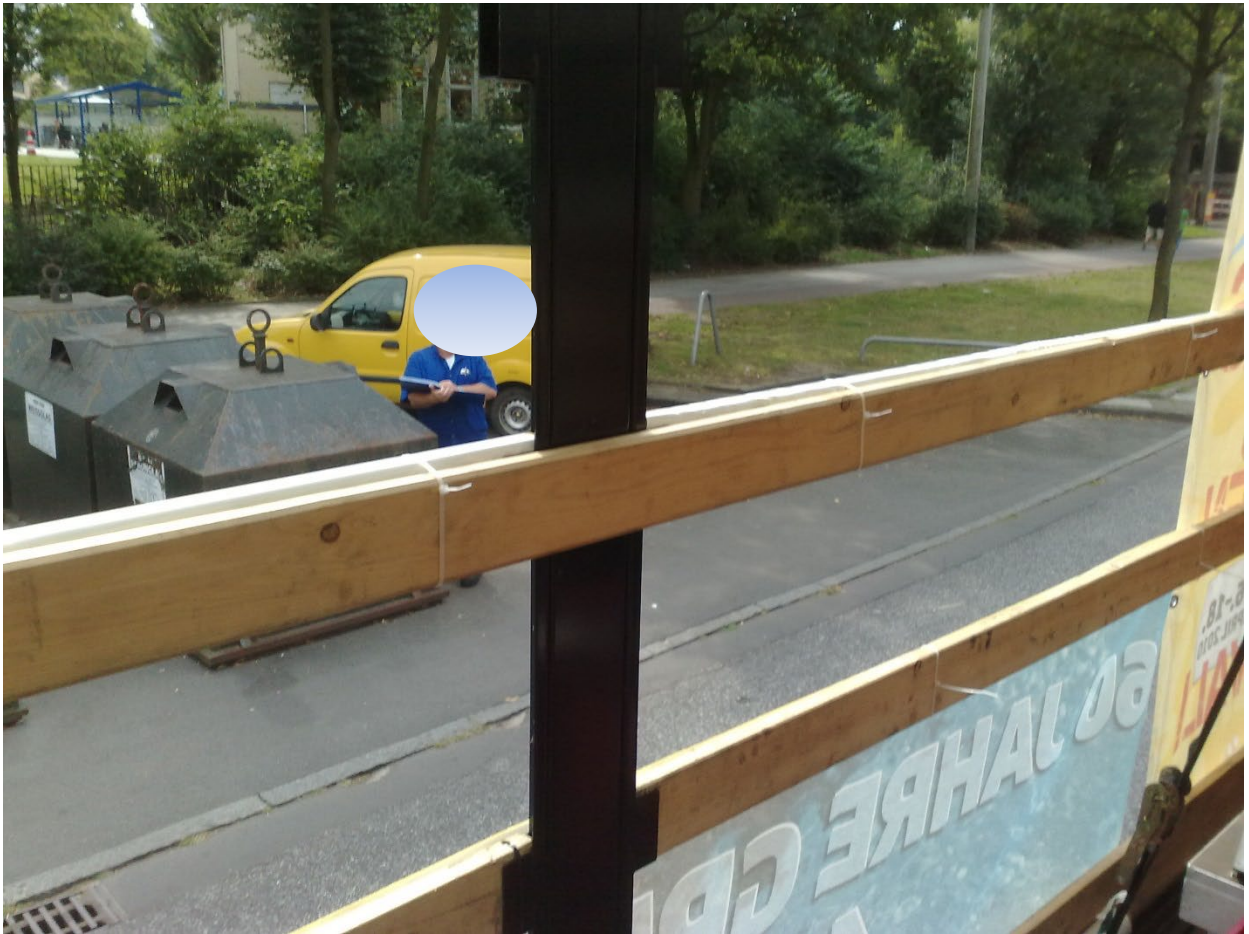
Verstärkung der Spriegel mit Überlappung gegen Herausdrücken
